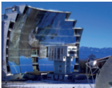
CNRS PROMES 1MW Solar Furnace, © Centre National de la Recherche Scientifique (CNRS)
